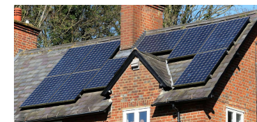
屋根に設置されたソーラーパネル
